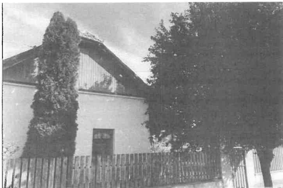
Az épület utcai homlokzata jellegzetes, deszkaborítású oromfal kiképzéssel
