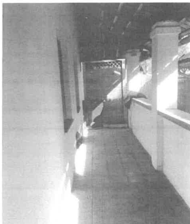
A vizsgált épület tornácának képe falazott oszlopokkal, falazott mellvéddel
