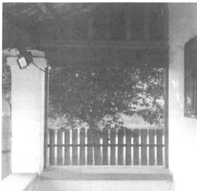
A tornác utca felőli vége, beforduló mellvéddel
