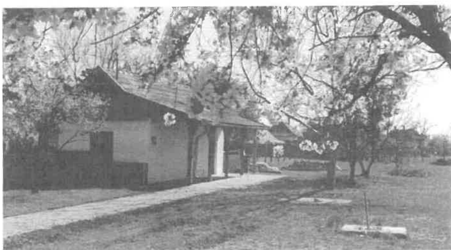
Helyreállított jászsági ház Jásziványon
