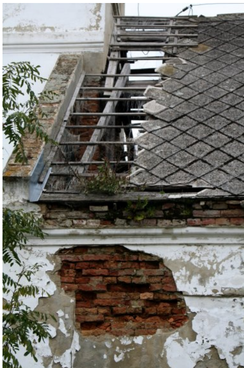
Folyamatban a Belsőfalusi templom felújítása
